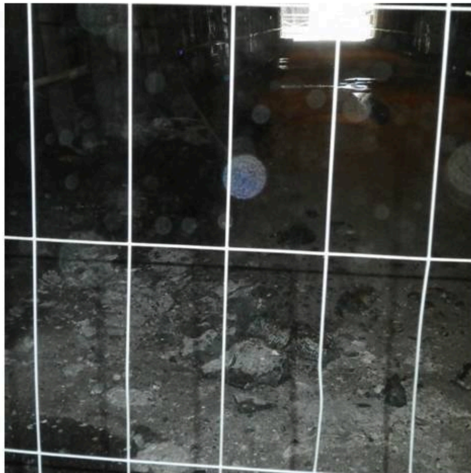
Ecaille béton 2m 2 tombée en notre présence le 21 avril
