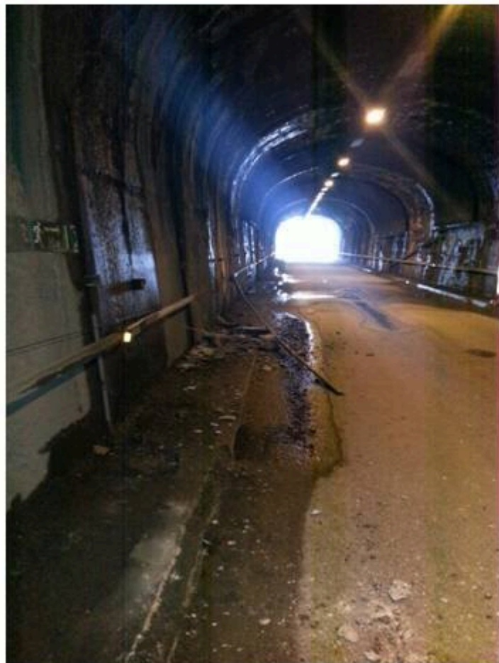
Ecaille béton 1m 2 tombée en notre présence le 16 avril
